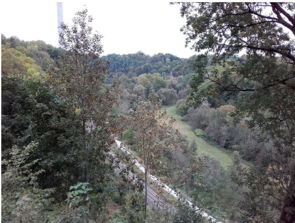
Neckartal auf Höhe der geplanten Brückenquerung (im Bild von links vorne nach rechts hinten knapp unterhalb der Baumkronen-Kante über das Tal spannend, dann nach hinten). Standort Dominikanermuseum.
