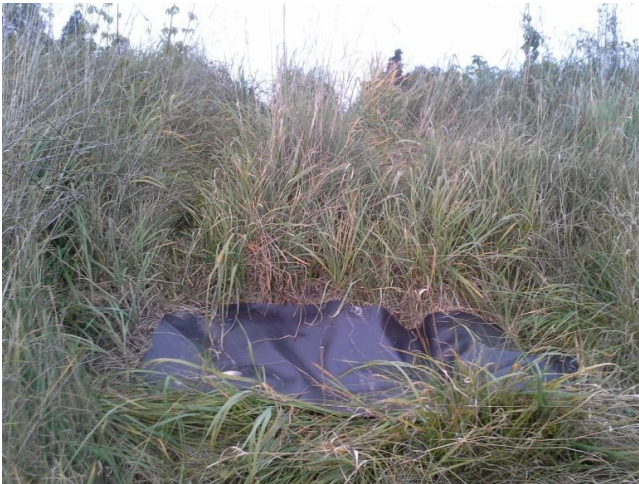
Abb. 25. An Grasböschung ausgelegtes KV
